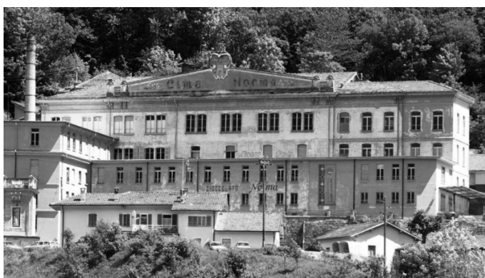
Completamento della facciata e dei volumi adiacenti
