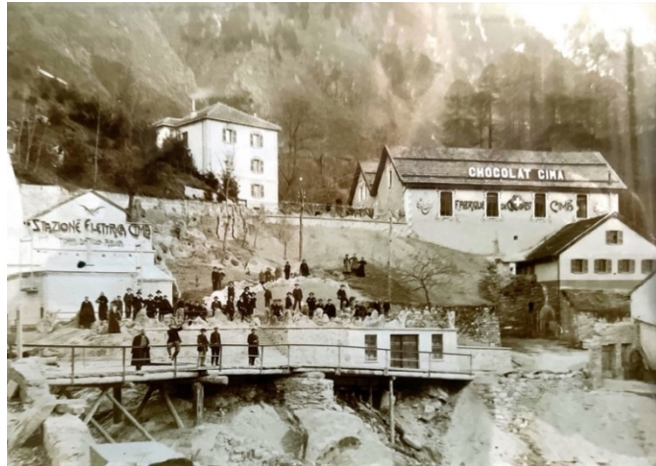
Sistemazioni davanti alla centrale a opera dei F.lli. Cima
