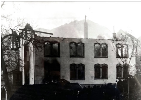
Retro della fabbrica a seguito dell'incendio del 1915
